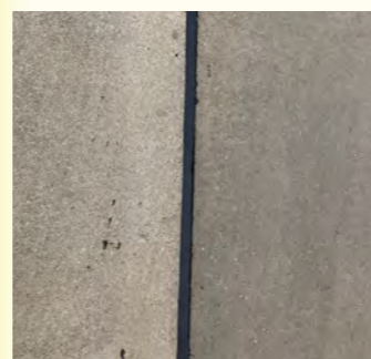
コンクリート舗装の目地補修
